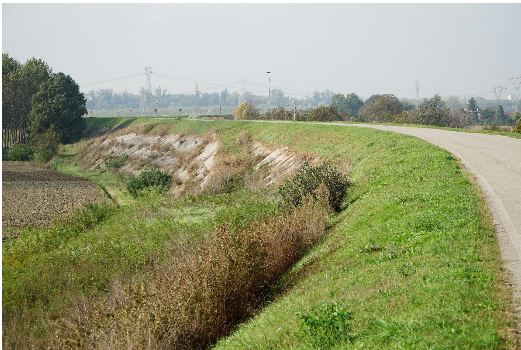
Figura 8 - Esempio di rivestimento in lastre in cls sul paramento lato fiume lungo il tratto oggetto di intervento.
